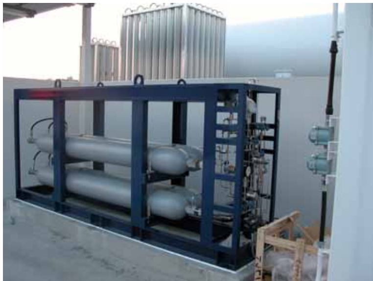
Mynd 12 Í bakgrunni til hægri sér á láréttan tank sem inniheldur vetni í vökvaformi. Pípurnar fyrir miðju er þrýsti- og kælibúnaður. Hylkin fremst á myndinni taka við vetninu sem gufað hefur upp. Hylki eru einnig notuð án kælibúnaðarins. Pípubúnað-urinn er um 2m á hæð. Myndin er tekin nálægt Tokyo í Japan þar sem opnaðar hafa verið yfir 10 vetnisstöðvar
